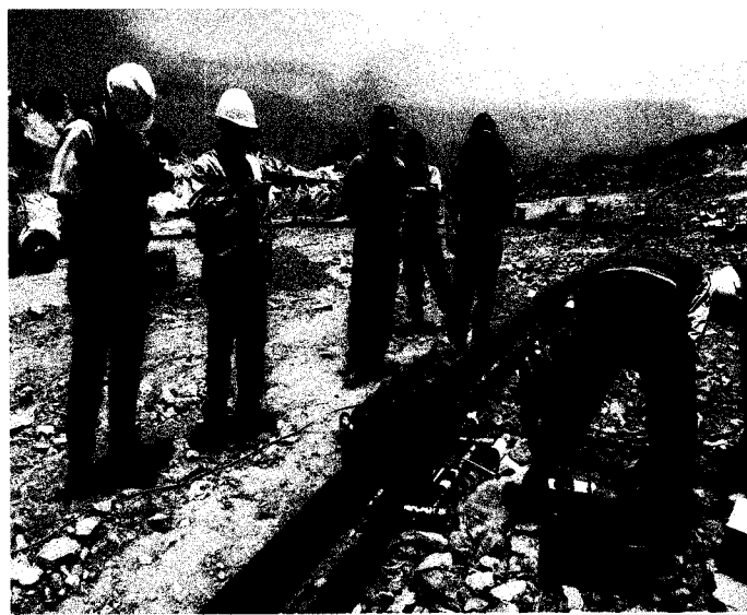
SUMINISTRO Y TERMOFUSIONADO DE TUBERIA DE HDPE
