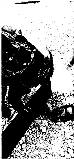
TERMOFUSIONADO DE TUBERIA
